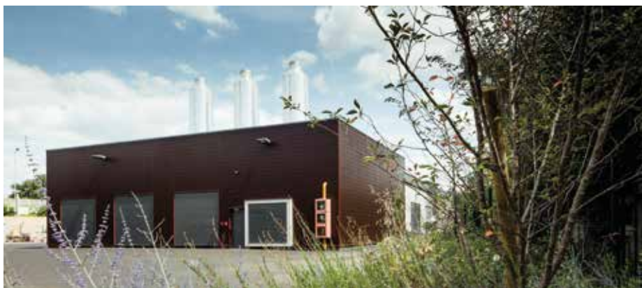
Centrale géothermique d'Arcueil et Gentilly (Val-de-Marne), qui alimente un réseau de chaleur.
